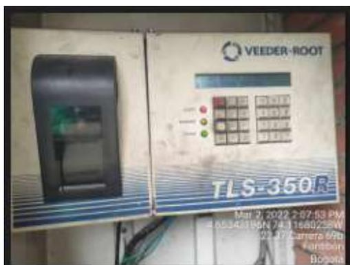
Foto 36. Detector de fugas Veeder-Root
